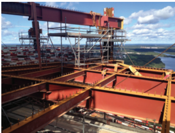
Slika 49 • Montaža nosilcev plošče.
