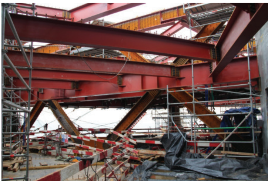
Slika 32 • Jekleno paličje prečnika v 33. in 34. etaži.
