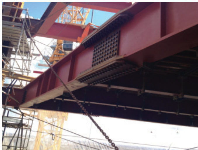
Slika 50 • Vijačeni stik nosilca plošče.
