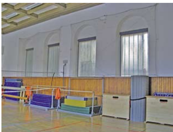
Slika 4. Primer nevarne postavitve športne opreme v športni dvorani.
