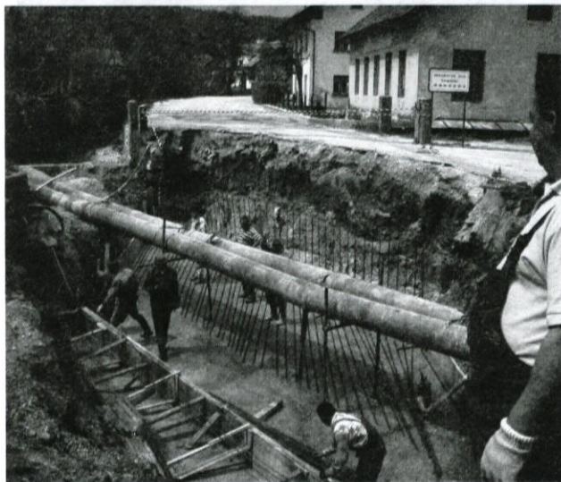
Gradnja novega mostu na Gorenjski.
