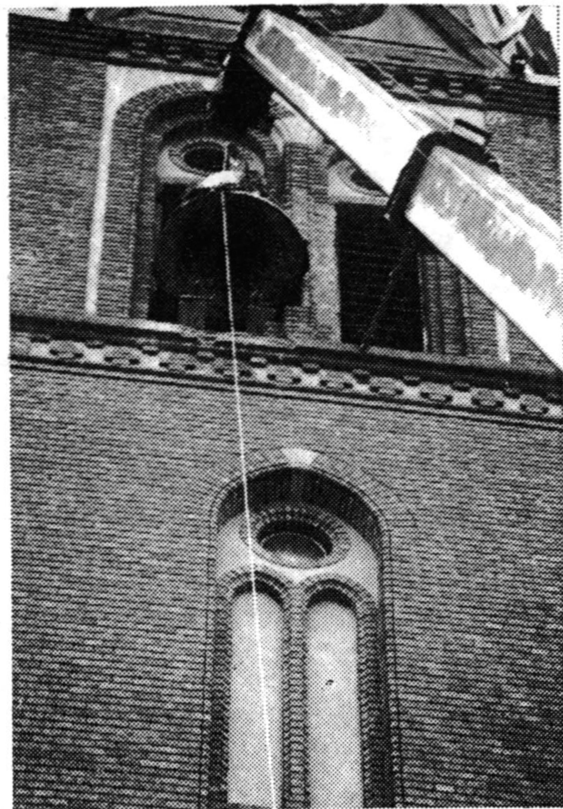
S posebnim avtodvigalom so v nekaj minutah dvignili zvon v zvonik (Foto: T. Medvešek).
