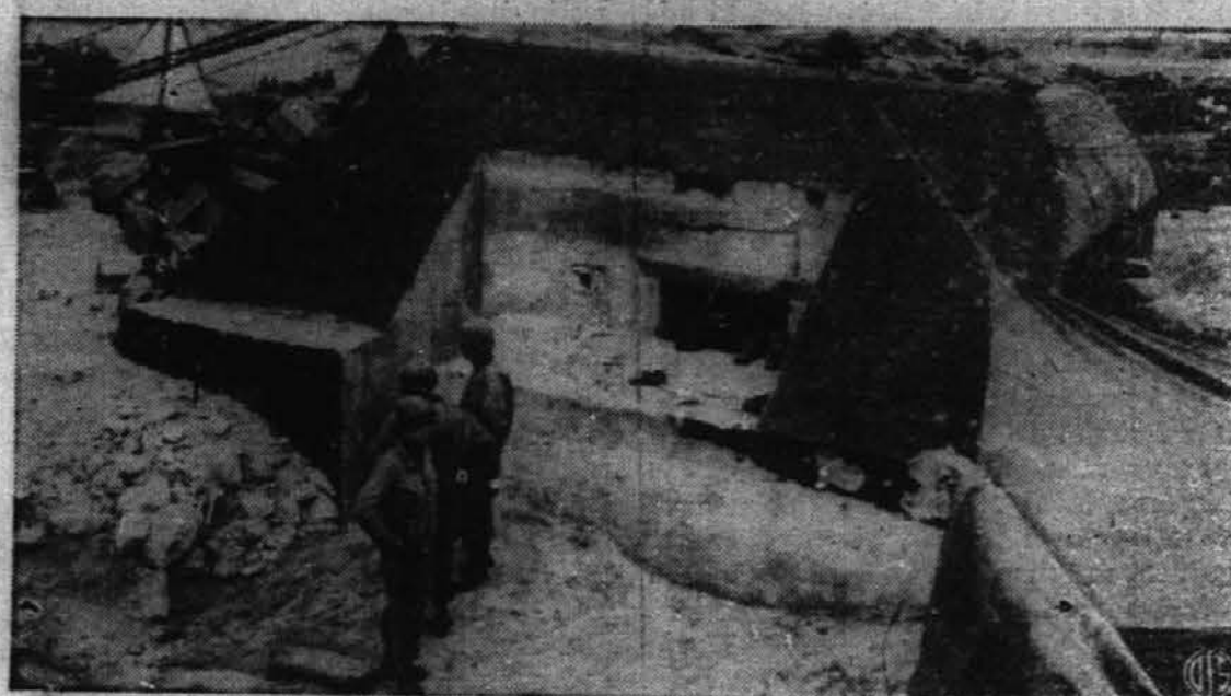
Tukaj je ena izmed utrdb v Hitlerjevi zapadni steni, ki se ni mogla ustavljati krogom iz ameriških topov. Krije del normandijskega obrežja. Zavezniki imajo zdaj tukaj svojo poveljniško postojanko.
