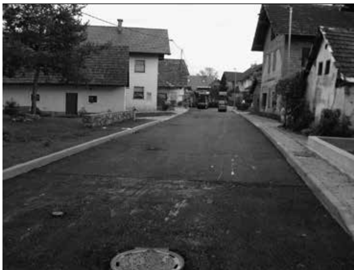
Težko pričakovan asfalt v Iški Loki
