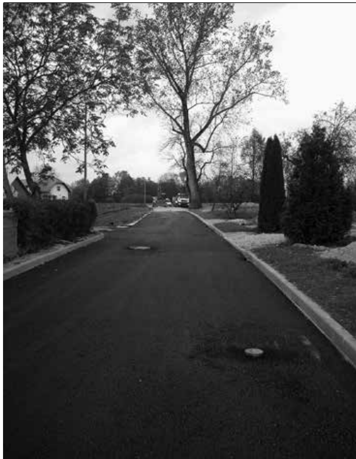
Asfaltiranje je potekalo v več fazah.
