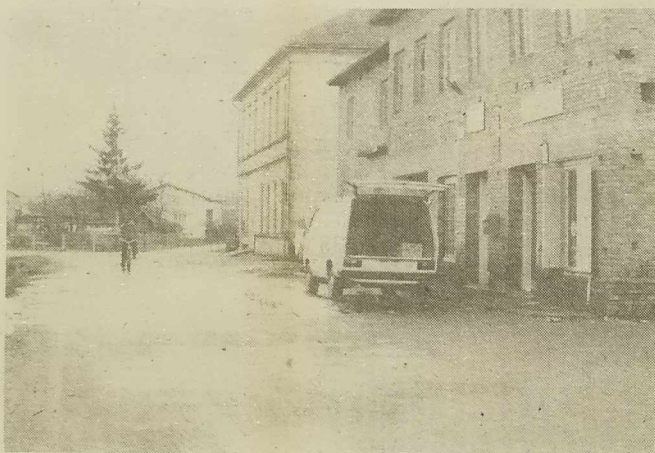
Vaški dom v Lipi, kjer je tudi trgovina in prodajalna KZ Panonka, ter neizkoriščena zgradba bivše osnovne šole.
