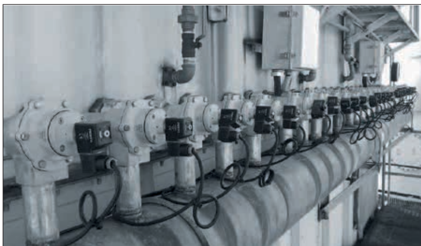
Slika 2. Vgraditev serije pulznih ventilov
