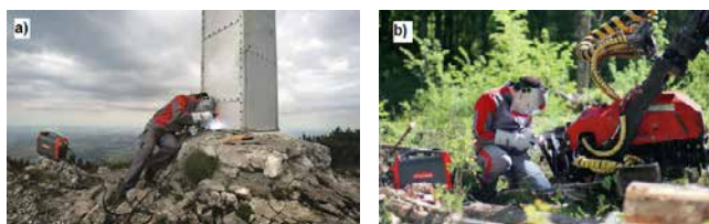
» Slika: a) varjenje nosilnega stebra na težko dostopnem terenu, b) varjenje glave harvesterja v gozdu
