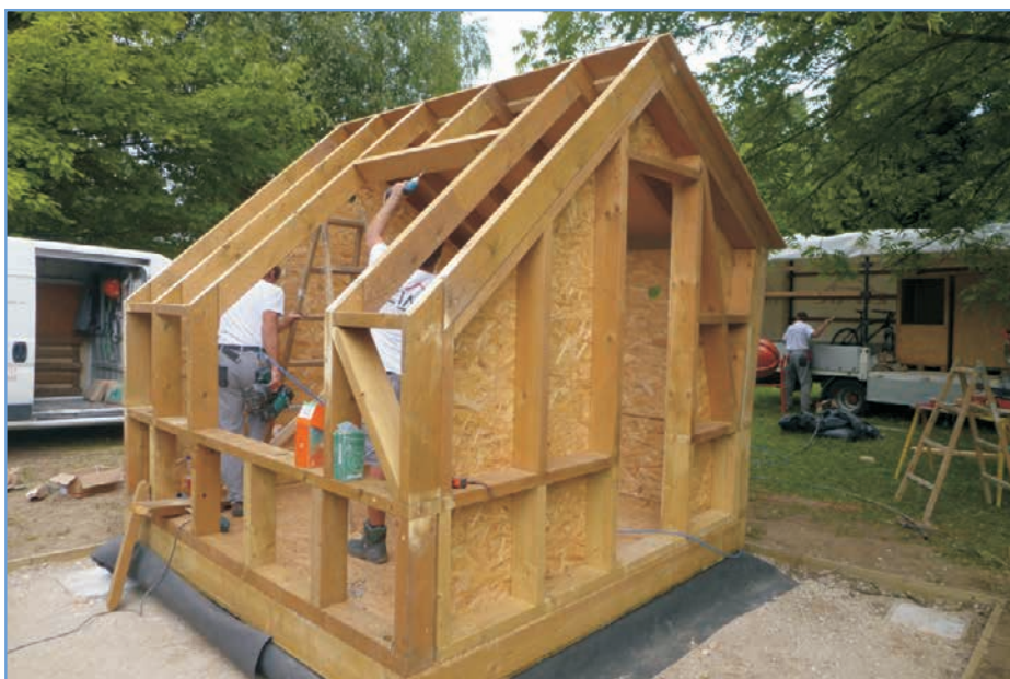
Slika 1: Gradnja modelnega objekta v skeletni izvedbi. Vrzeli v skeletu so bile nato zaplunjene s celulozno izolacijo Zimicell.
