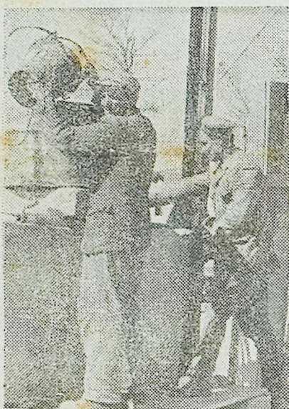
Žična žaga za rezanje marmornatih plošč
