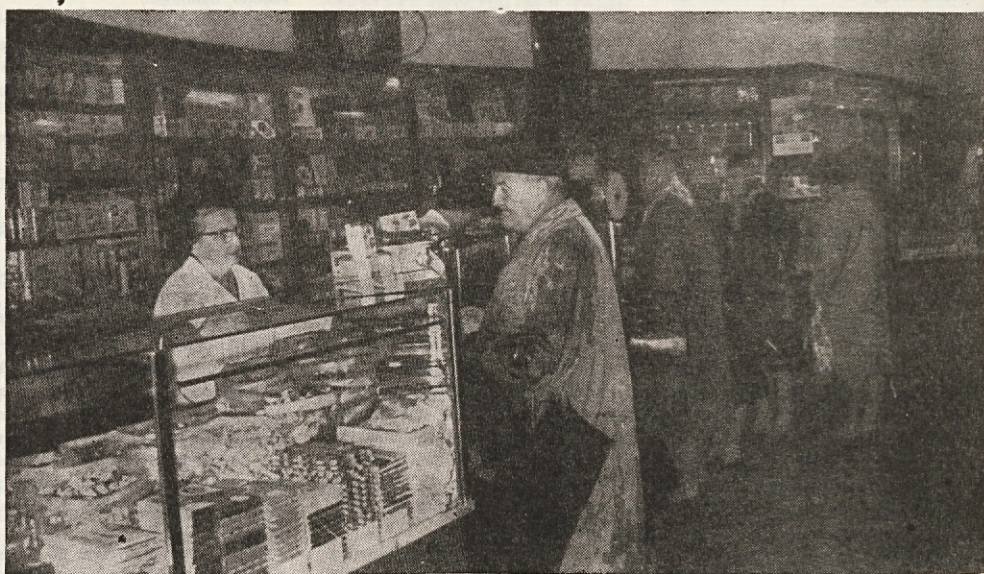
DE Trgovina in njeni delavci so se odločili za samostojno TOZD
