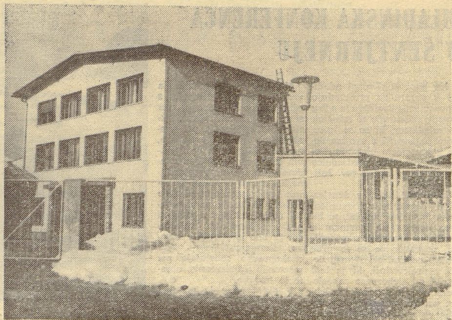
Pročelje tovarne električnih instrumentov v Otočah
