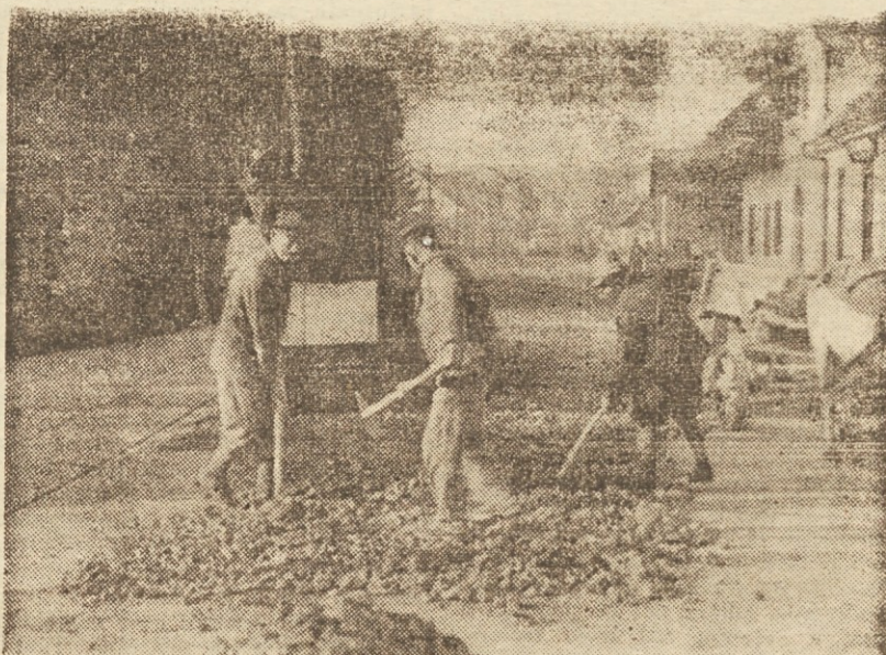
Pripravljalna dela za kockanje Tržaške ceste.
