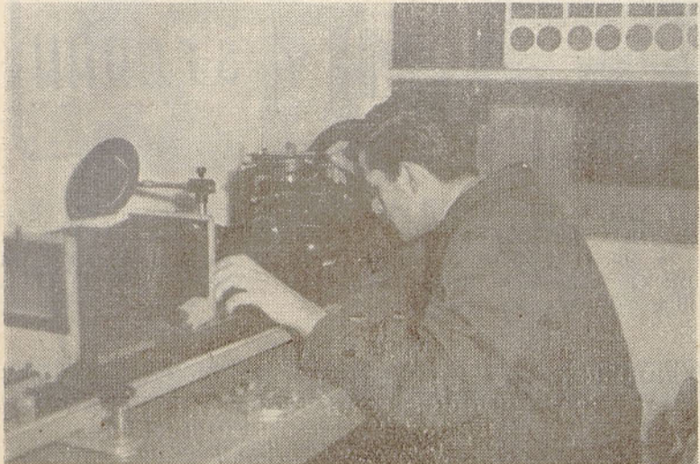
V razvojnem oddelku je tudi metalografski laboratorij. Na sliki je prikazano delo na sodobnem metalografskem mikroskopu
