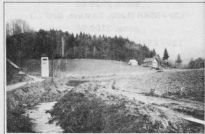
Potok Stopnica je zdaj urejen tako, da ceste ne bo več poplavljal.
