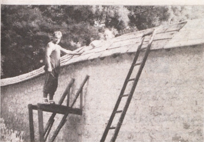
TUDI OBZIDJE POTREBUJE STREHO - Kartuzijo Pleterje obdaja 2600 metrov dolgo visoko obzidje, kateremu že dlje časa obnavljajo streho iz skrilavca. Delo opravljajo trije Hrvati iz zagorskih krajev, strokovnjaki za tako prekrivanje. Plošče ustreznih velikosti režejo iz velikih skrilastih plošč, ki so prej prekrivale zdaj večinoma že obnovljene večje samostanske strehe. (Foto: T. Gošnik)
