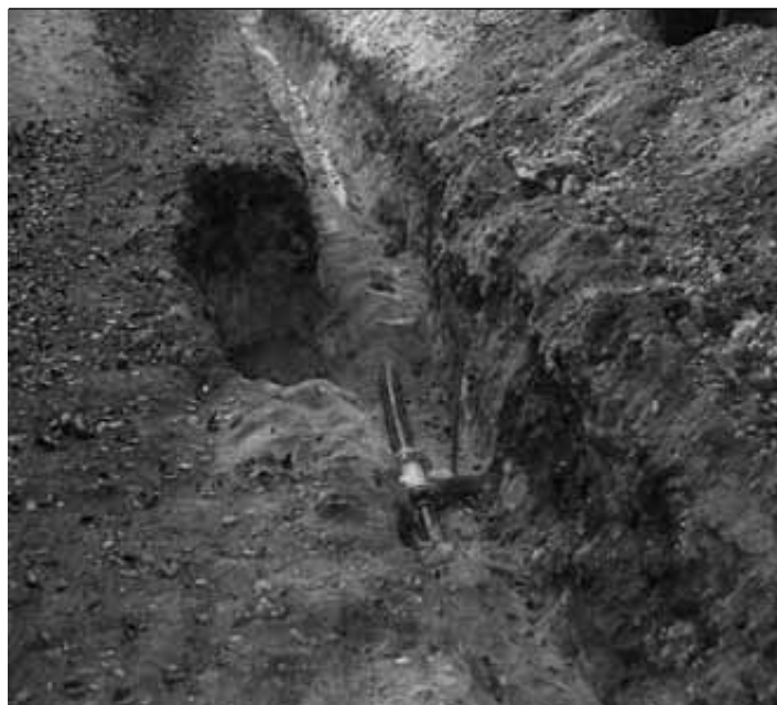
Obnova vodovodnih priključkov
