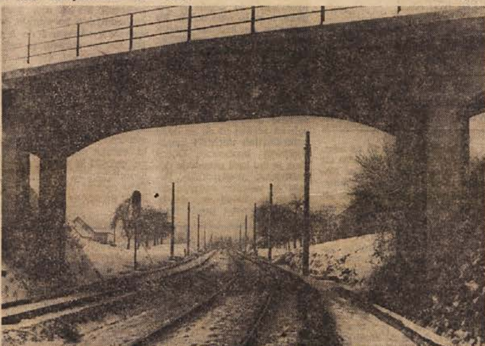
ZELEZNICARJI OBLJUBLJAJO , da bodo električni vlaki že letos vozili do Dobove. Tako bo proga elektrificirana od Jesenic do Dobove, vsi pa upamo, da se bodo njihovi načrti tudi uresničili! — Na sliki: drogovi so postavljeni že vse do Sevnice. (Foto: Franc Pavkovič)
