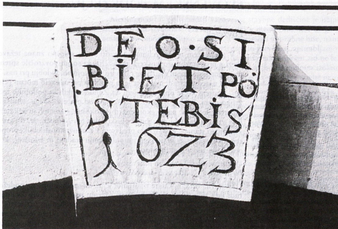
Sklepni kamen nad portalom novomeške proštije (1623); foto: Zvone Pelko
