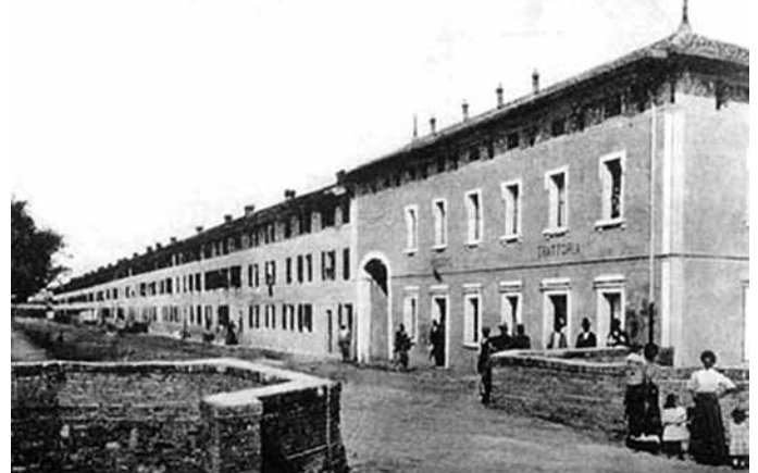
TORRE DI ZUINO - Villa Vecchia
