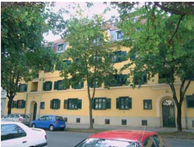
Abb. 24: Vorderansicht straßenseitig. Fig. 24: Street view.
