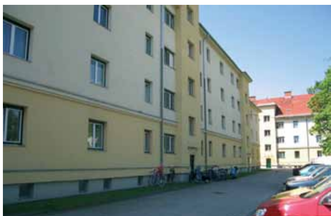
Abb.18: Innenhof Karawankenzeile 3-7. Fig. 18: Inner courtyard, Karawankenzeile 3-7.
