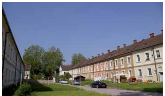
Abb. 19: Steyr, Wehrgraben. Fig. 19: Steyr, Wehrgraben.
