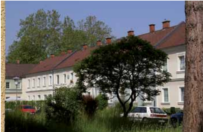
Abb. 20: Steyr, Wehrgraben. Fig. 20: Steyr, Wehrgraben.
