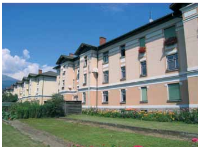
Abb.10: Wohnanlage Carl-Wurmb-Weg 4-10 (a+b), Vorderansicht. Fig.10: Apartments at Carl-Wurmb-Weg 4-10 (a+b), Vorderansicht.
