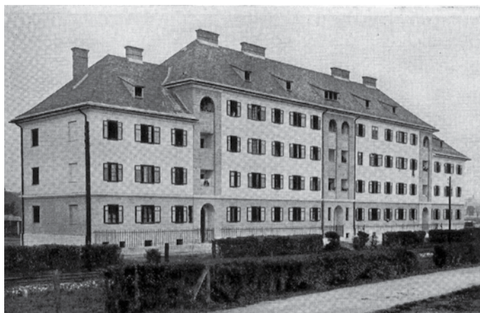
Abb.16: Tabakarbeiterheim, 1. Ausbaustufe 1929. Fig. 16: Tobacco workers residence in 1929.
