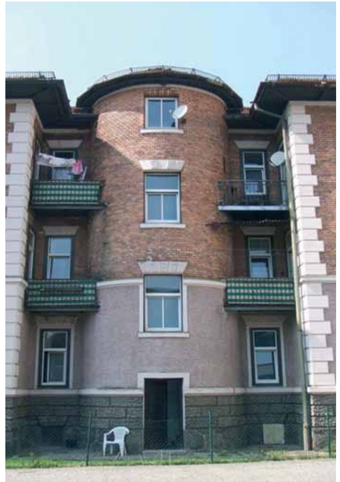
Abb.15: Rückansicht. Fig. 15: Rear Façade, part.
