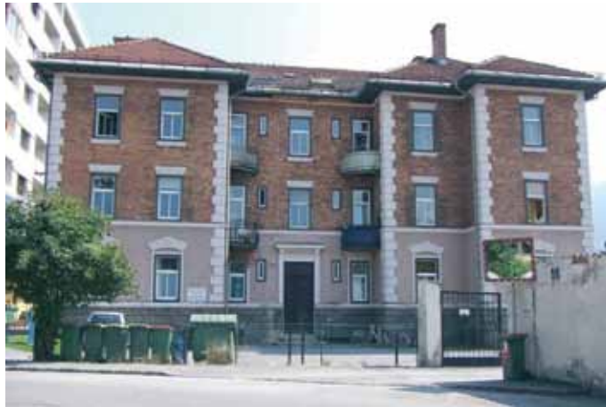
Abb.13: Vorderansicht. Fig. 13: Front Façade.
