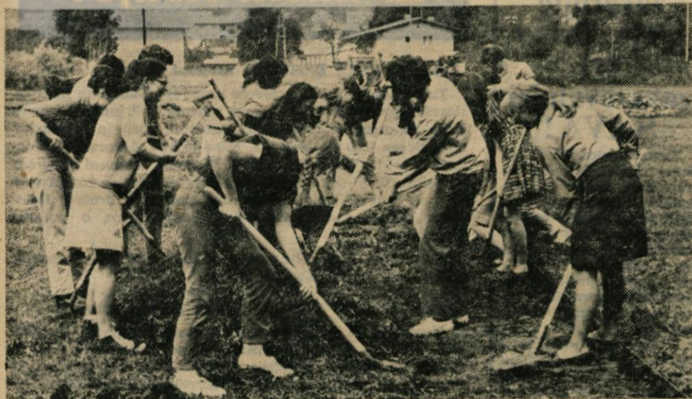
V Mekinjah pri Kamniku so začeli graditi športni stadion. Z delom so začeli mladinci in mladinke. Delovno akcijo je organizirala obč. konf. ZMS Kamnik
