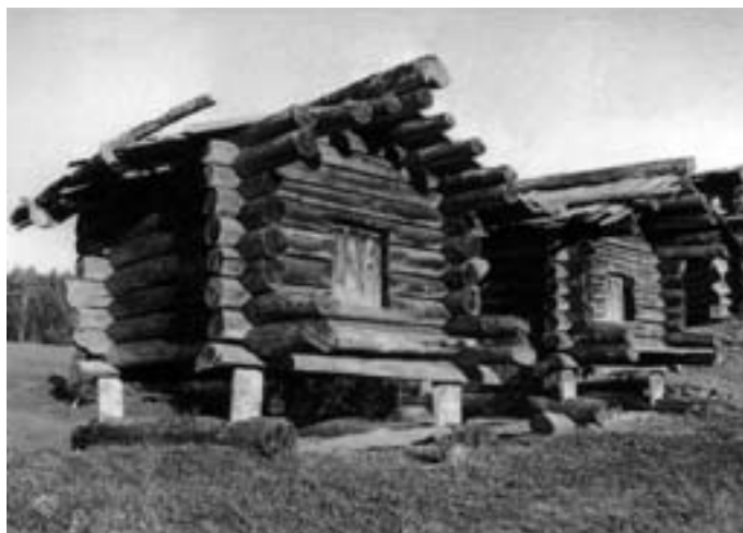
Slika 4: Kašče v vasi Konima. Strešna konstrukcija s slemenskim tramom: šelomom (slov. šlemom), ki tesni vzdolžne deske, ležeče na legah. Barns in the Village of Khornima, 1973.
