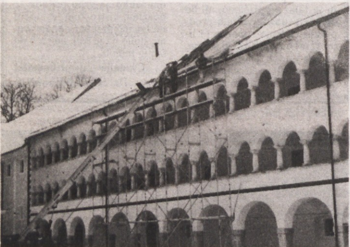
PREKRIVANJE STREHE SE NADALJUJE - Med obnovitvenimi deli, ki že potekajo, je tudi prekrivanje z novo strešno opeko, saj je stara dotrajana. Tudi v teh mrzlih dnevih delavci vztrajajo. (Foto: L. M.)
