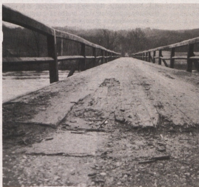
MOST V BORŠTU - Na mostu je zdaj že precej lukenj, ki so ostale za drobljenimi deskami. Bolj od teh jam zaskrbljuje dejstvo, da se most poseda. Kako dolgo še? (Foto: L. M.)
