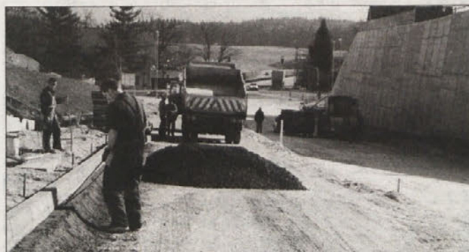
SEVERNA OBVOZNICA - Dela pri gradnji novomeške severne obvoznice potekajo po načrtih. Če bo šlo tako naprej, bo obvoznica končana najkasneje do konca junija. (Foto: A. B.)
