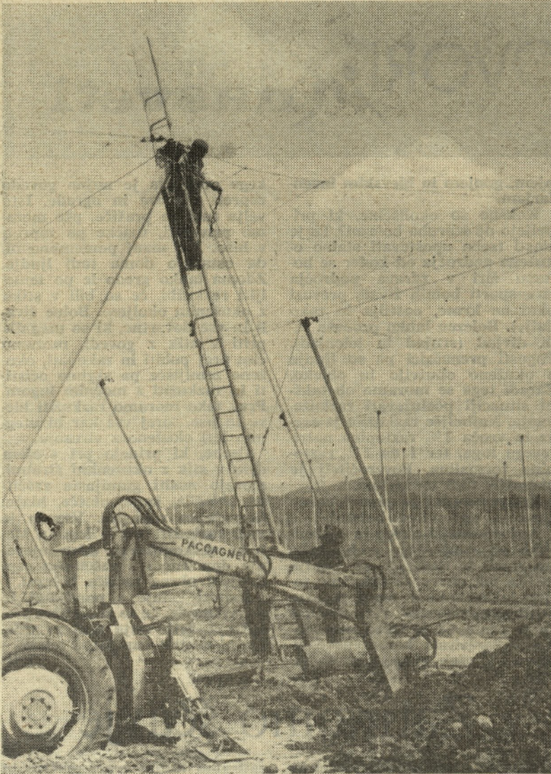
Po dveh slabših letinah pričakujemo letos boljšo. Zato močneje sidrijo vogalne stebre betonskih žičnic. Dela so hitro opravili, ker pri izkopih uporabljajo traktorske priključke
