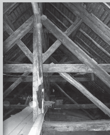
□ Slika 6. Segment vešala, ki deluje kot togo paličje
