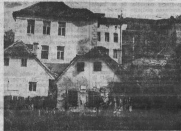
Pogled na južno stran gimnazijskega poslopja in na sosednji dijaški dom
