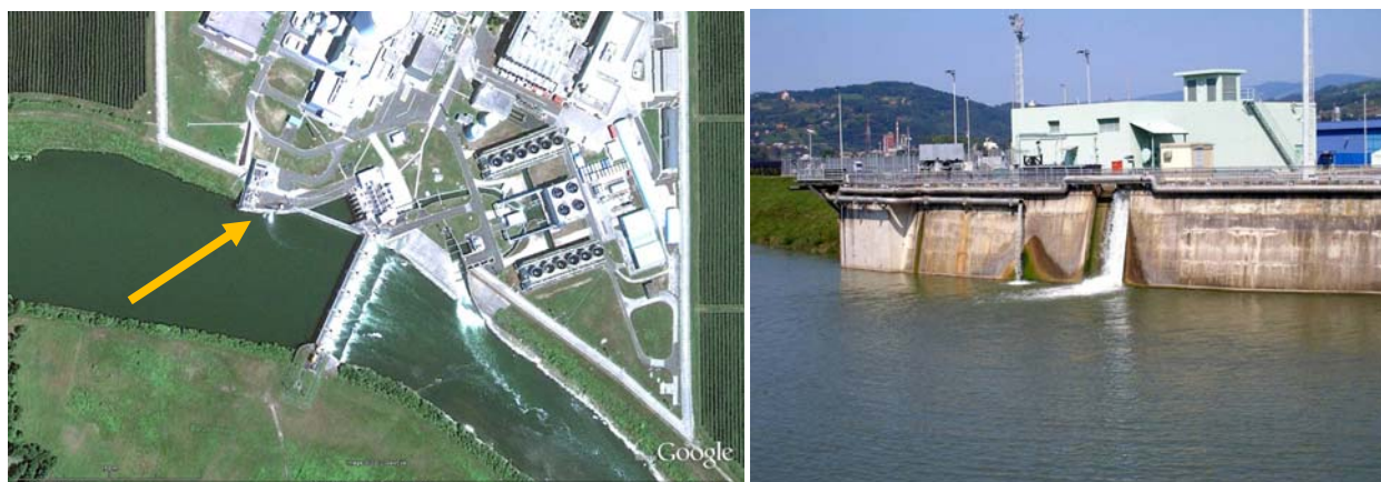
Slika 1.1: Izhod bistvene oskrbne vode (ESW), kjer se izpuščajo radioaktivne tekočine iz WMT in SGBD
