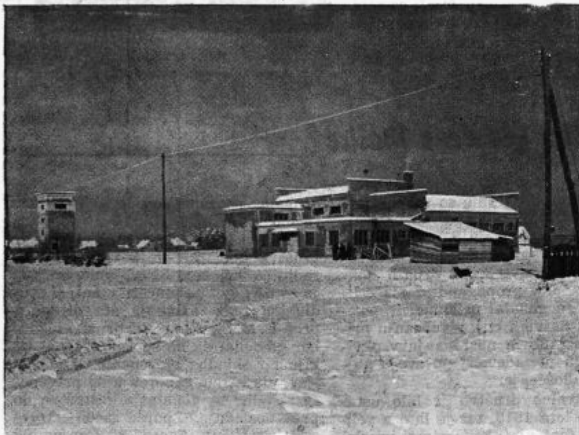
Pogled na novo relejno radijsko postajo na Teznem pri Mariboru. Na levi transformatorska hišica.
