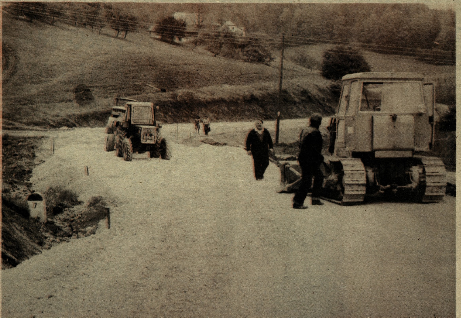
Gradnja ceste Andraž — Velenje
