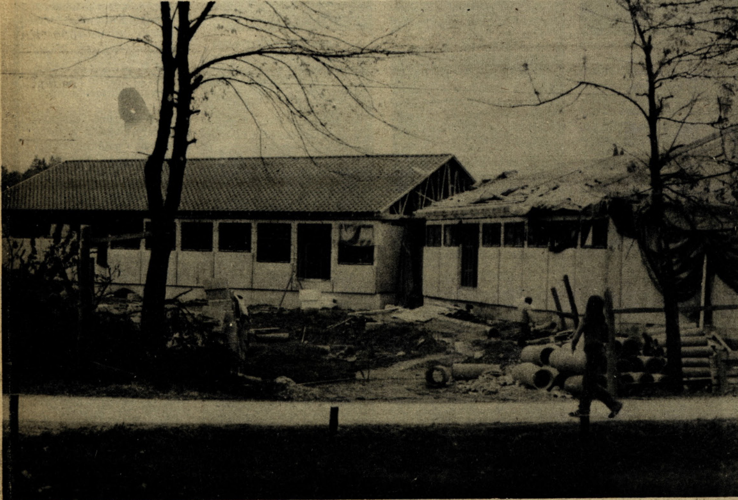
Preboldski vrtec v gradnji
