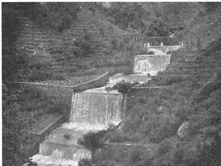
Biecas, Španija; ureditev hudournika Aras z zaporedjem zidanih pregradb prvega in drugega reda za utrditev struge in vegetativno vezanje narušenih pobočij. (Orig.)
