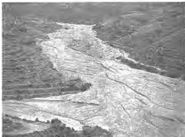
Provincia Huesca, Španija; pogozdovanje območja hudournika Los Cuñols v porečju Río Noguera Ribagorzana, ki se vrši na izorane vodoravne police. (Orig.)
