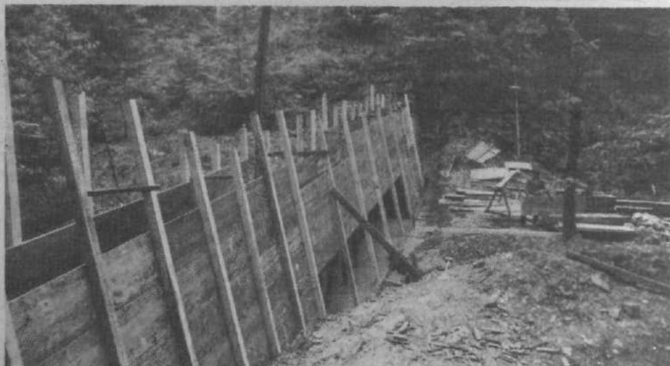
Največ dela je bilo z zadrževalno zaporo na Klemenčevem grabnu, ki bo zadrževala prodnati material. Zapora je široka 45 m, na najvišjem mestu pa meri 3 metre. Zaradi podražitve del bodo Zaborški hudourniki uredili šele prihodnje leto, Klemenčev graben pa bodo takrat uredili do izliva v Lisco.
