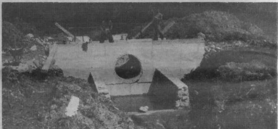
Druga, manjša zapora je na Penkačevem hudourniku, ki bo v kratkem urejen do izliva v Lisco, torej tudi pod cesto in mimo dolske graščine - v skupni dolžini okrog 500 m. Dela so bila zelo zahtevna, saj so morali odstraniti veliko nanešenega materiala.
