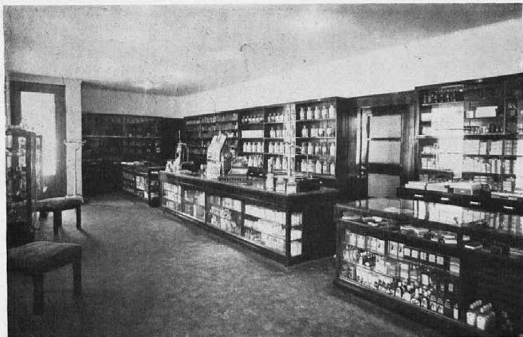
Arch. Jože Mesar, Ljubljana Drogerija Kanc Notranjost Mizarsko delo ing. Remec & Co.
