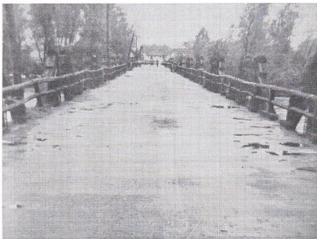
Most v času porušitve, 8. 5. 1966 (Hrani arhiv Okr. drž. tož. na Ptuj)
