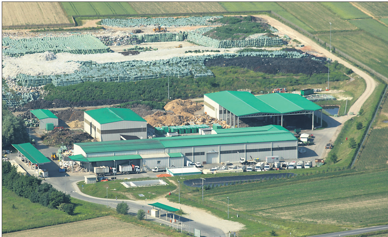
Z nadgradnjo projekta naj bi se višina odlagalnih polj povečala za štirikrat - s štirih na 16 metrov.
