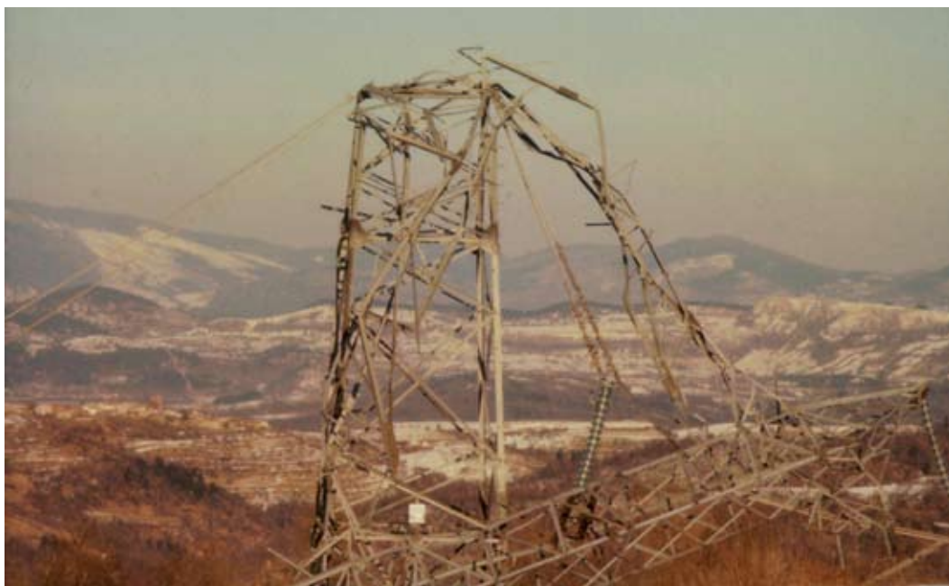
Slika 2: Zaradi teže ledenega oklepa in vetra je bilo na območju Brkinov novembra leta 1980 zelo poškodovano tudi daljnovidno omrežje. (Vir: Arhiv GIS)
