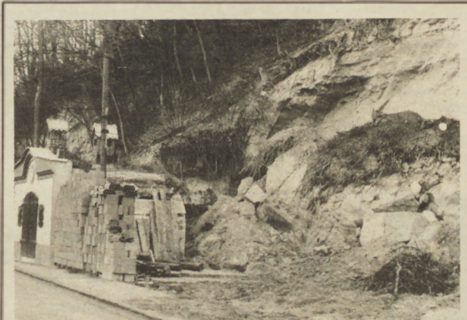
Grob poseg v naravo je vzrok tudi za rušenje zemlje tik ob ulici Miška Kranjca v Lendavi. Mar se nihče ne zaveda, da se zaradi spodkopavanja strmega hriba načenja večja površina, ki lahko zdrsne na cesto, prekine promet in uniči hiše. Takšne in podobne posege v naravo bo potrebno takoj prepovedati. J. D.
