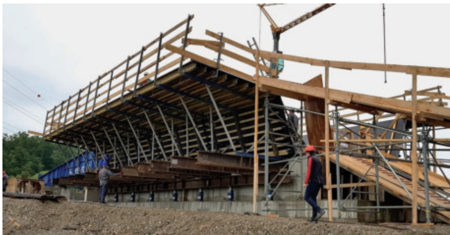
Slika 25 • Pogled na končano delavnico za narivanje.
