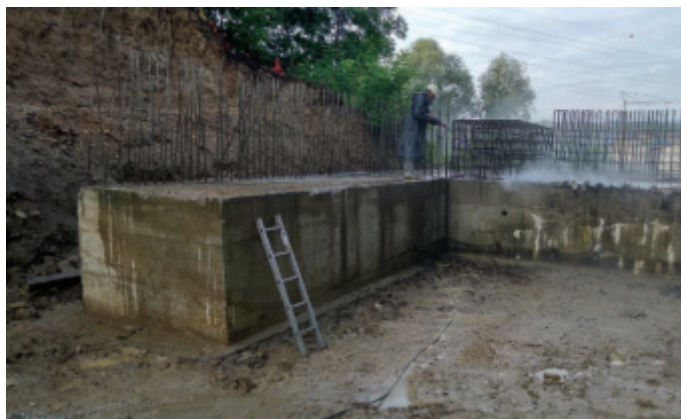
Slika 20 • Čiščenje betonskih površin z vodnim curkom.
