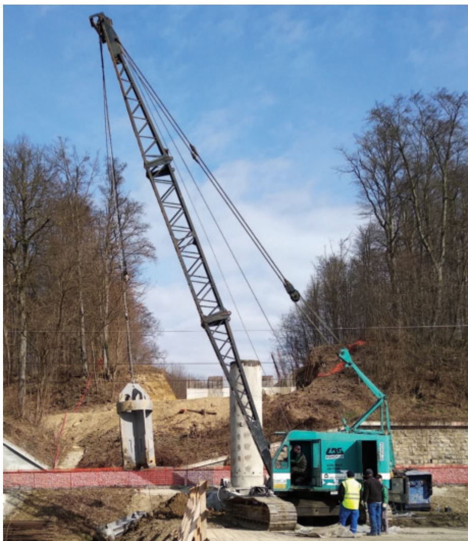
Slika 11 • Izvedba pilotov Benotto v osi 6.
