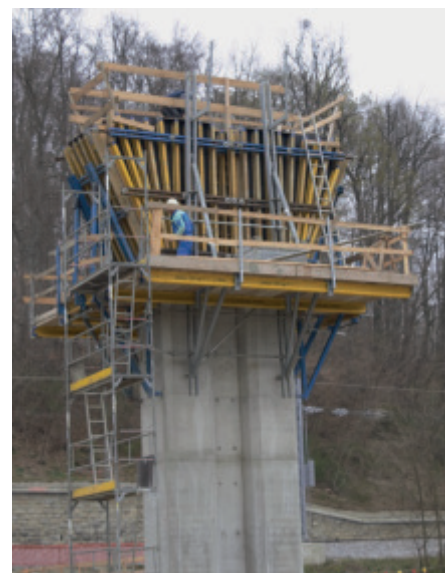
Slika 16 • Opaž razširjenega zgornjega dela stebra.
