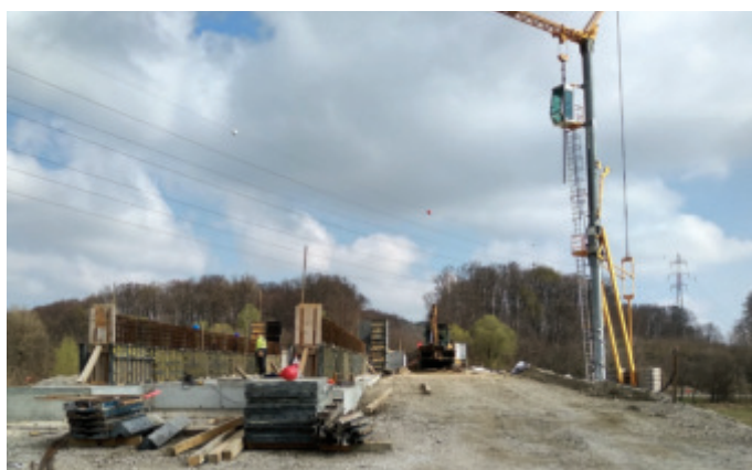
Slika 18 • Gradnja narivne delavnice v osi 1.
