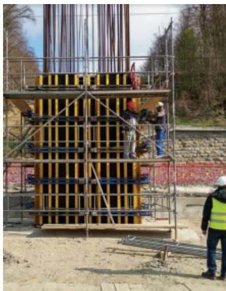
Slika 14 • Opaž spodnjega dela stebra.
