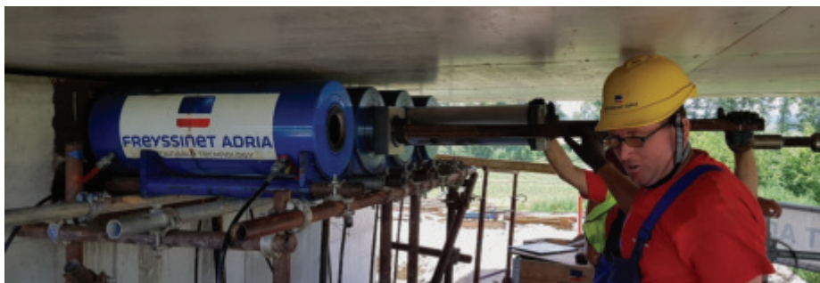
Slika 27 • Vlečni votli hidravlični cilindri z vijaki Freyssibar.
