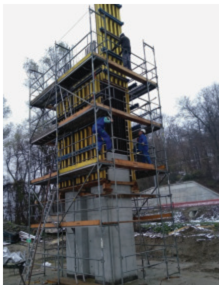
Slika 15 • Opaž vmesnega dela stebra.
