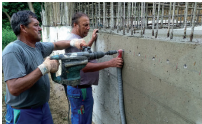
Slika 21 • Vrtanje lukenj za sidrno armaturo.
