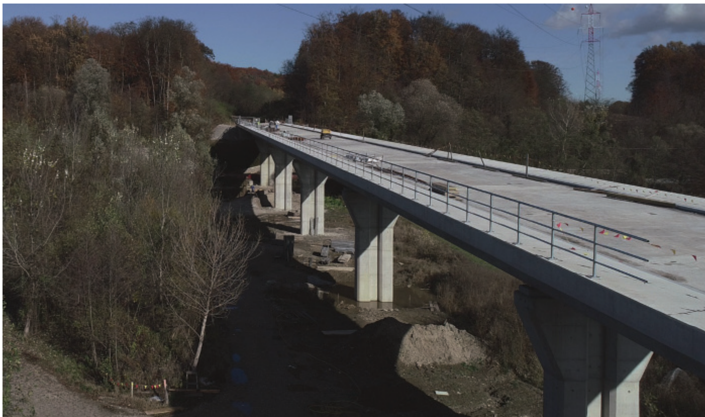
Slika 32 • Viadukt v fazi gradnje.
