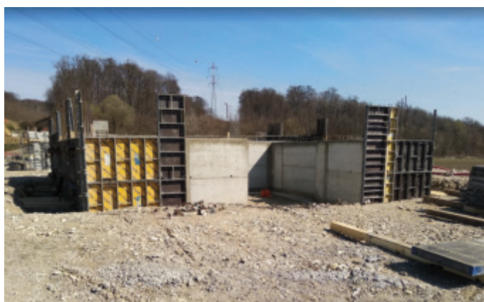
Slika 17 • Gradnja opornika v osi 1.
