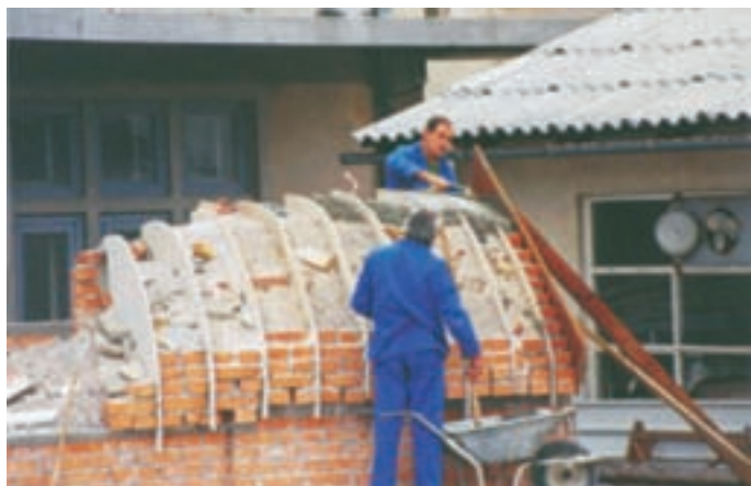
Slika 12: Izdelava hidravličnega modela omočenega dela lupine v merilu 1:1. (foto: Primož Banovec) Building the hydraulic model of the wetted part of the shell in scale 1:1.
