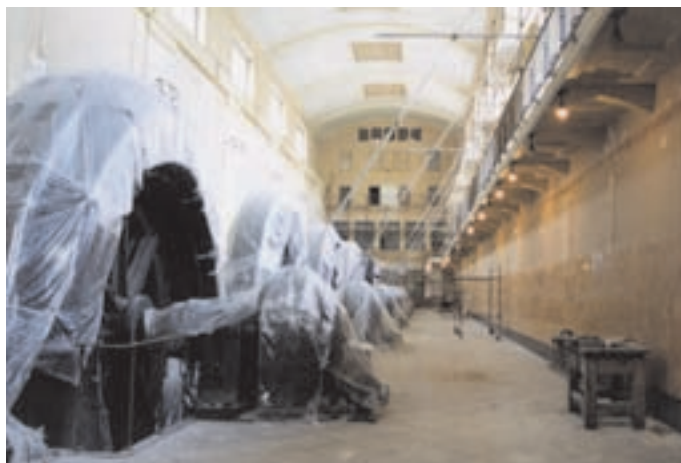
Slika 5: Začetek prenove. Beginning of renewal.
