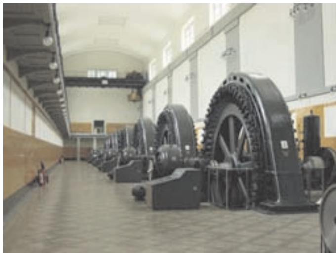
Slika 3: Prenovljena strojnica. Renewed power house.
