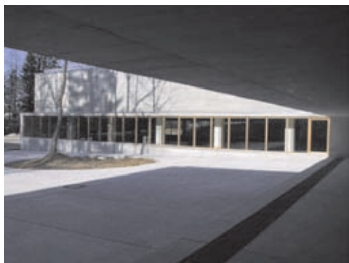
Slika 10: Vhodni nadstrešek. Entrance canopy.
