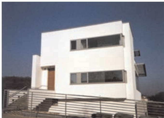
Slika 4: Zapadna (ulična) fasada. The west (street) elevation.
