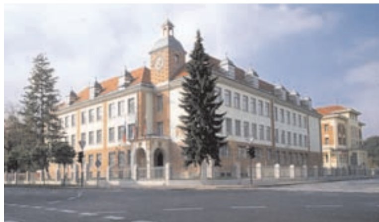
Slika 1: Pogled na kompleks. View of the complex.
