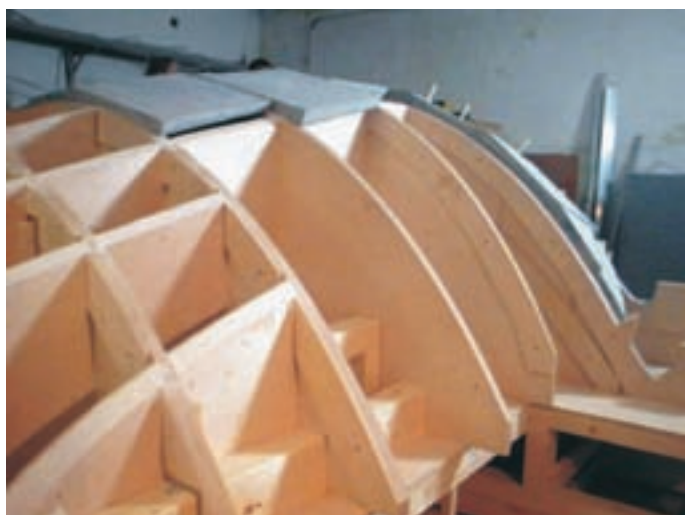
Slika 13: Spodnji profili za izdelavo lupine. (foto: Marmor Hotavlje) Bottom profiles for building the shell.
