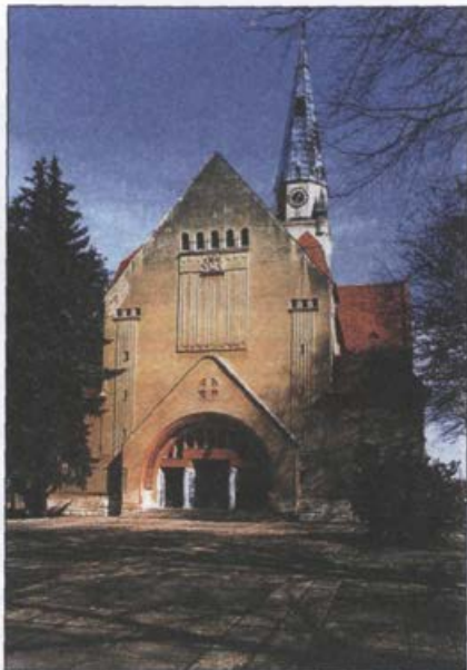
Zunanost sedanje soboške cerkve. V levi stranski zunanji zid je vgrajen rimski nagrobnik, ki je bil najden na tem mestu.
