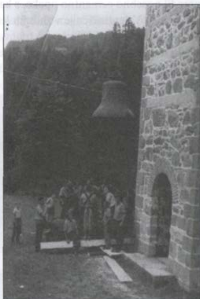
Rečica, dviganje zvona
