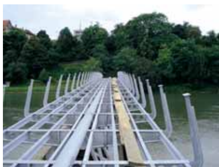
Slika 13 • Montaža sekundarne konstrukcije (junij – avgust 2007)
