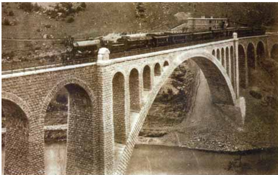
Otvoritev bohinske železnice dne 19. 7. 1906. Dvorni vlak na železniškem mostu v Solkanu pri Gorici.
