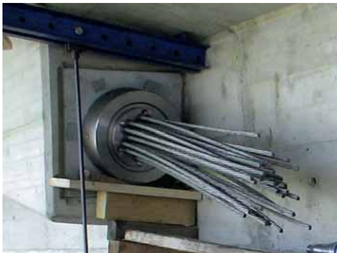
Slika 15 • Fotografija sidrišča poševnih zateg
