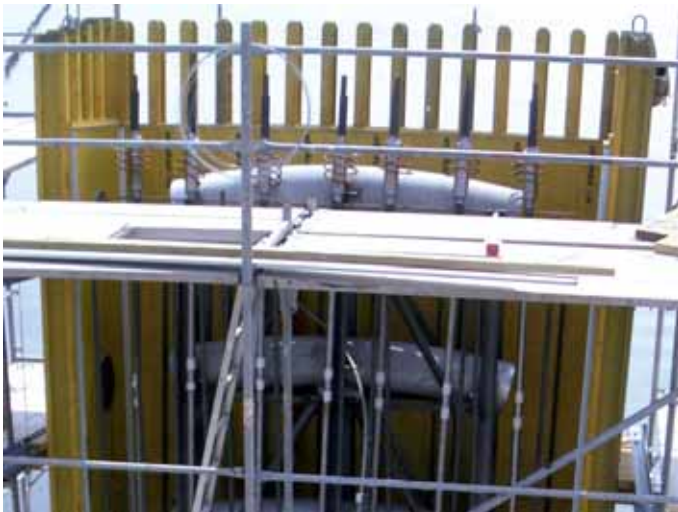
Slika 11 • Fotografija vstavljene kletke z deviatorji v opaž pilona in palicami za prednapenjanje
