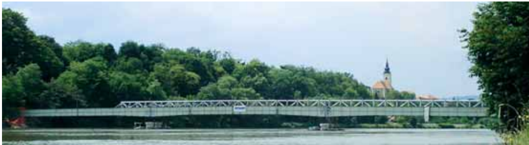
Slika 12 • Montaža nove nosilne konstrukcije na obstoječo (maj – junij 2007)
