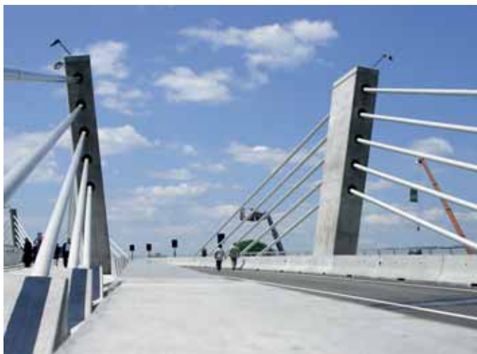
Slika 3 • Fotografija nedokončanega vozišča mosta
