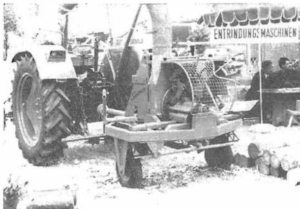
Majhen prevozni stroj »Schälhexe« za drzanje ce- luloznega lesa
