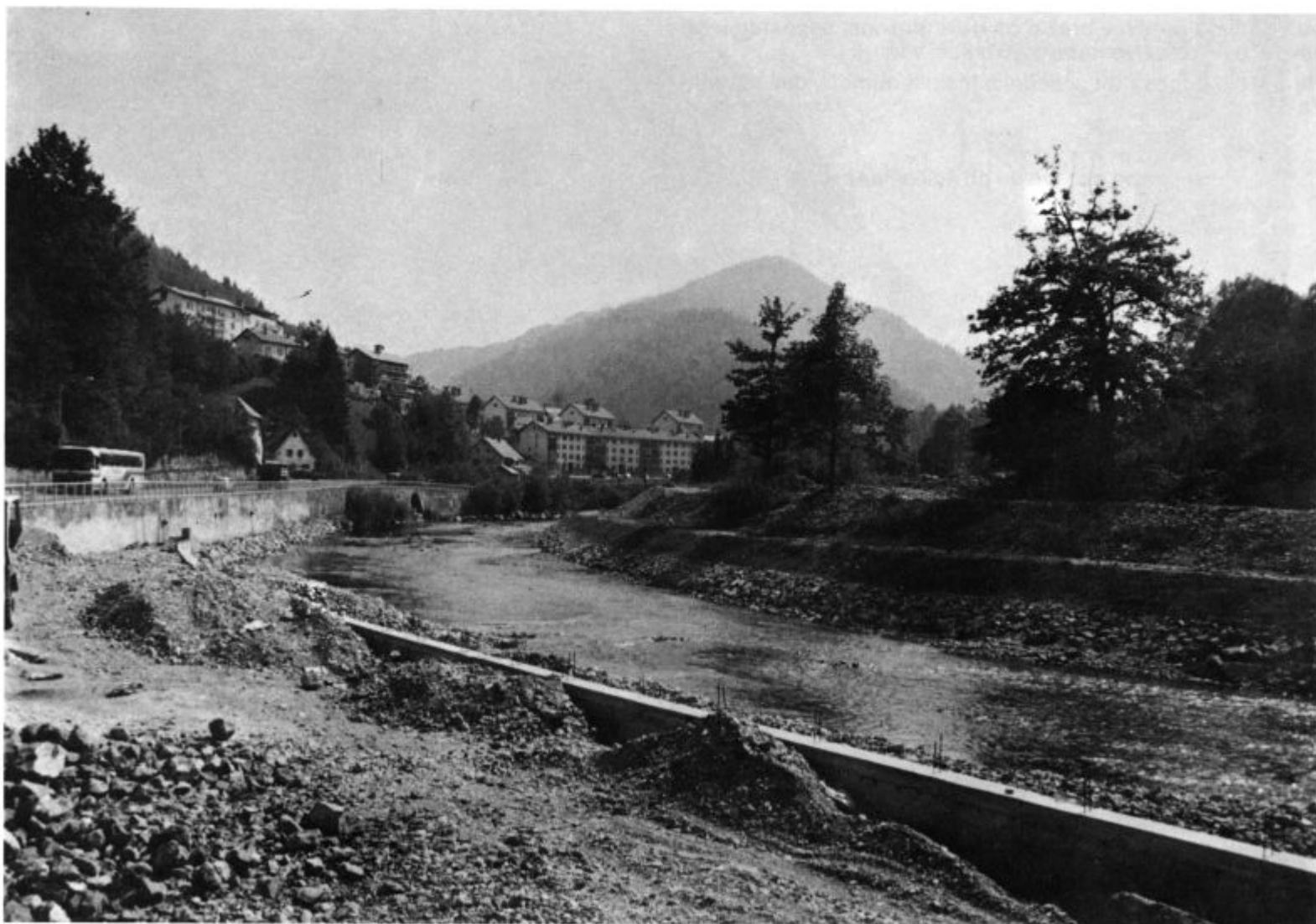
Ureditvena dela v strugi Idrijce pri Debeli skali (foto: Drago Petrovčič, 1987)
