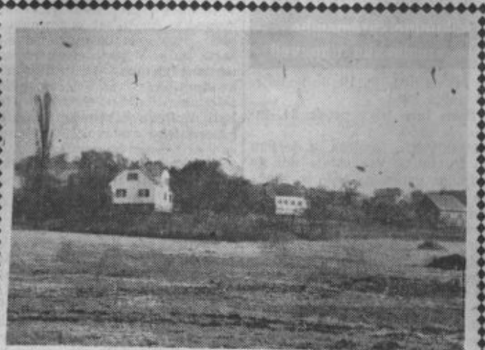
Prej travnik pod Krambergerjevo in drugimi hišami — sedaj veliko gradbišče enodružinskih hiš
