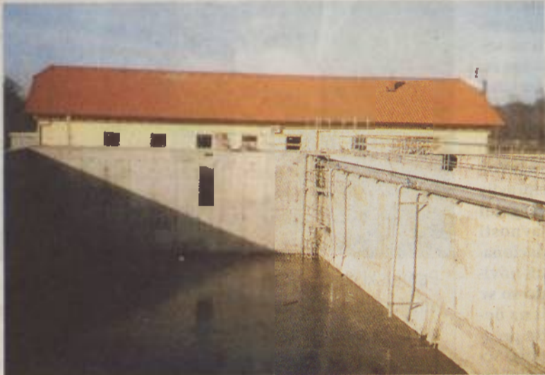
Gradbišče nove čistilne naprave
