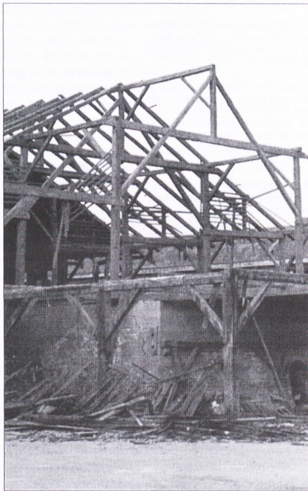
Staro Treppovo opekarno, zgrajeno leta 1903, rušijo, na njenem mestu bo stala moderna betonarna. Šentlenart pri Brežicah, oktober 2000. Foto: I. Počkar.
