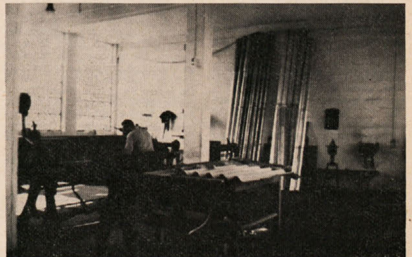
Izdelava cevi v kleparski delavnici v obratih na Lavi
