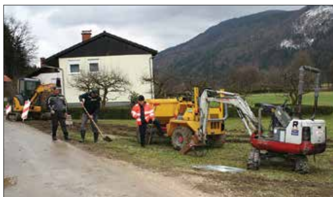
Svoje zadovoljstvo zaradi novih luči so krajanji Šutne izrazili tudi tako, da so priskočili na pomoč pri urejanju zemljišča po vkopu napeljave. (Foto: Marija Lebar)
