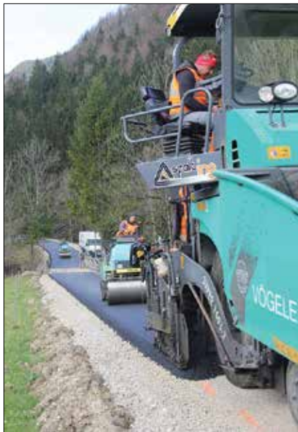
Polaganje asfalta na cesti Zgornji Podpečnik (Fotodokumentacija Občine Luče)
