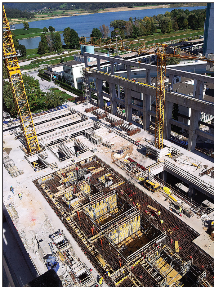
Temeljna plošča za blok 6
