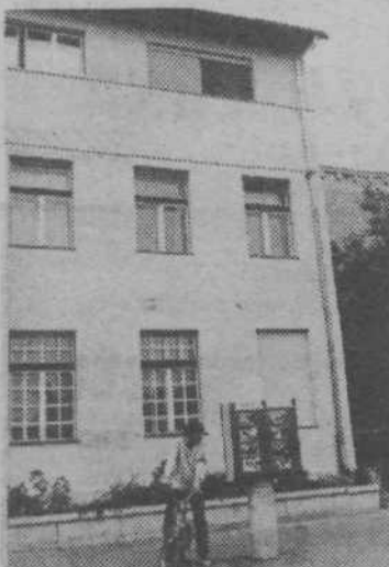
Prenovljena fasada glasbene šole (Foto: DJ)
